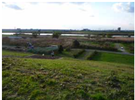
写真 9 古ヶ崎浄化施設 （全体に覆土してあり、それとはわからない）
