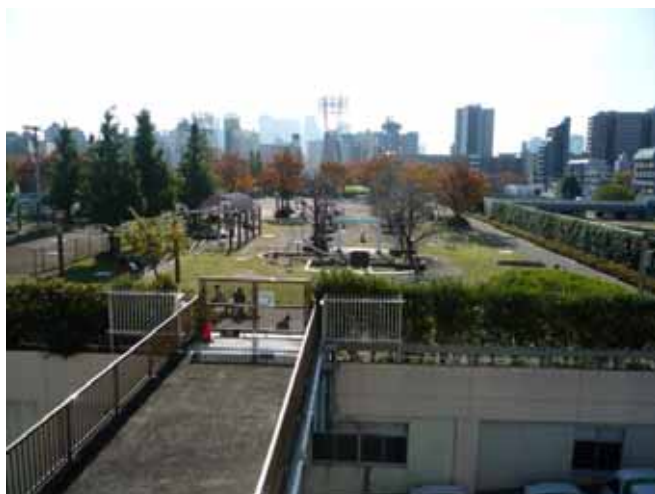
写真 11 落合水再生センター （上部の公園化は東京都で最初だった）
