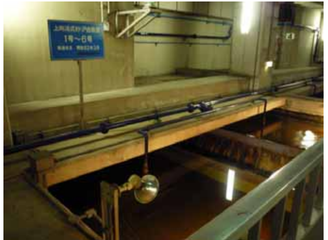
写真 12 砂ろ過設備
