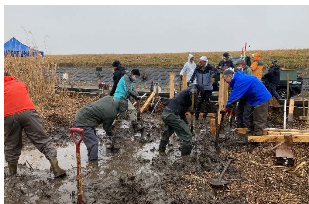
泥まみれで水路掘りと魚道の組み立て
