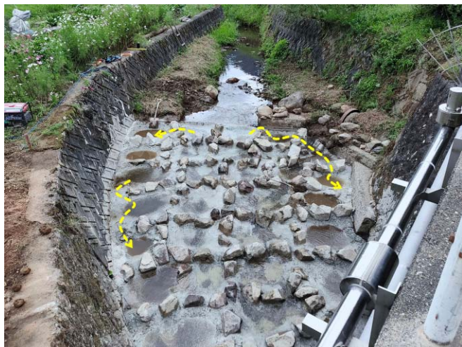
図2 施工直後の試験通水の様子 (破線矢印：通水しなかった魚道両側部の3箇所)
