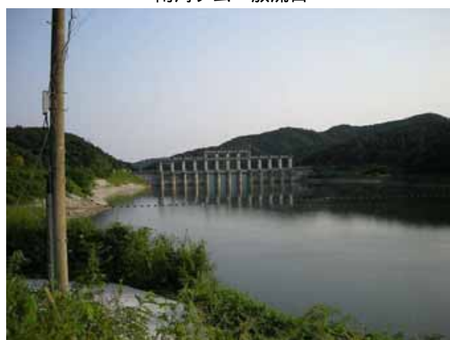
南河ダム 放水路ゲート
