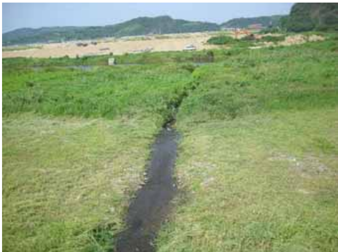
南河 改修中の本川堤防
