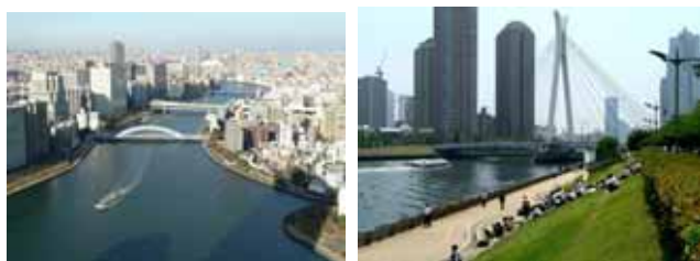
現在の隅田川 ( 提供: 東京都建設局河川部 )
