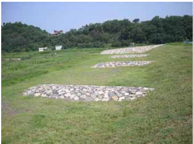
南河 支川導流堤
