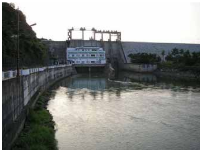
南河ダム 放流口
