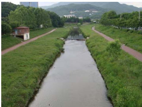
再生前の状態に近いと考えられる施工区上流 (ヤンジェ川)
