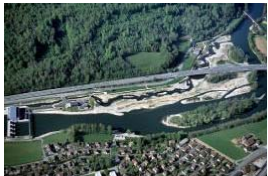
Ruppoldingen (アーレ川) のバイパス魚道
