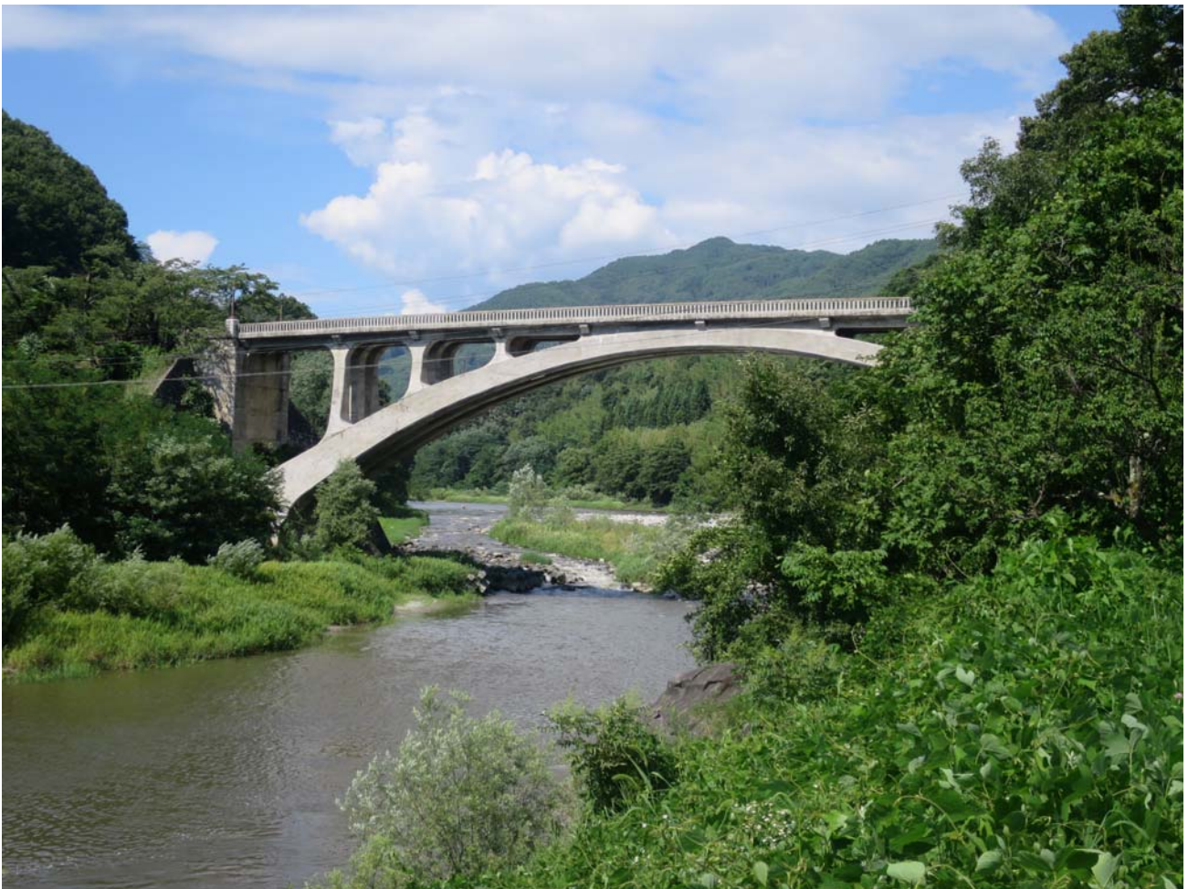
撮影：2017年8月（長野県上伊那郡・坂戸橋）
