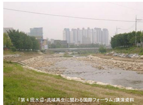
上下流の連続性確保を目的に堰を撤去（韓国・安養川）
