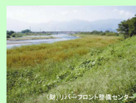
高水敷を掘削し、自然の攪乱作用を活かした事例（日本・千曲川）
