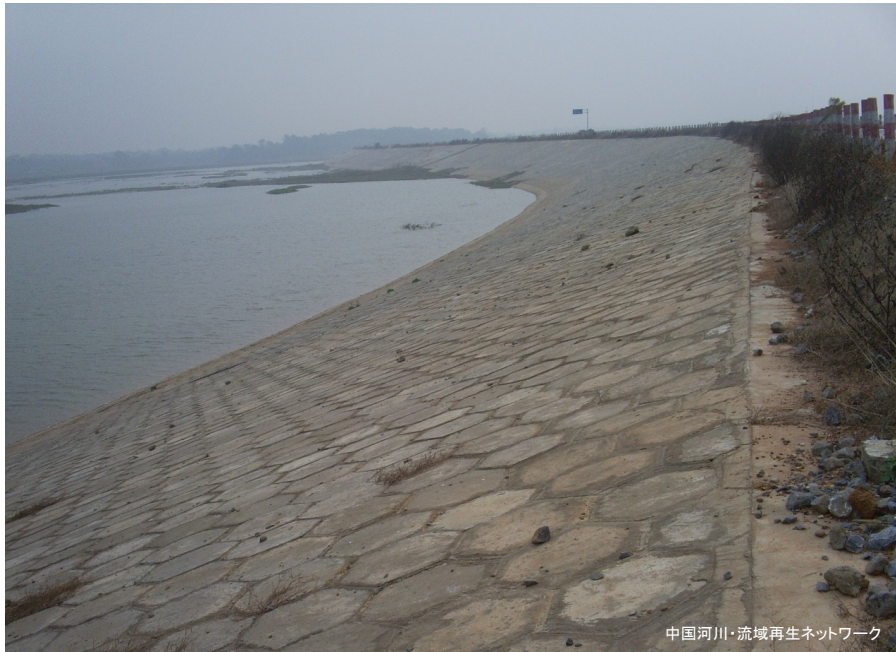
コンクリート護岸に覆われた人工的な河川（中国）
