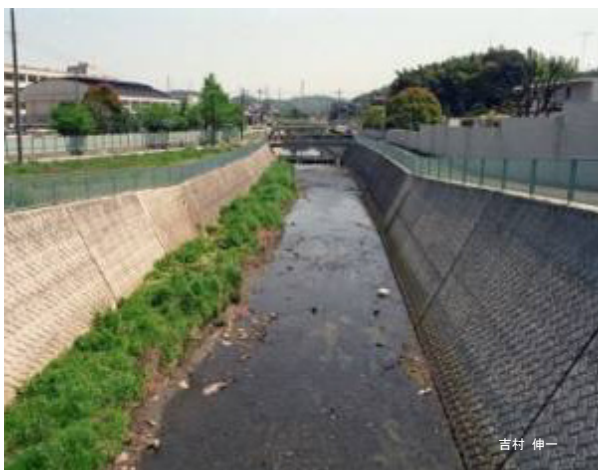
護岸による横断方向の連続性の消失 （日本・いたち川）
