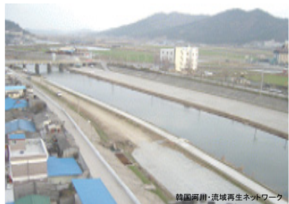
直線のコンクリートで固められた水路（韓国・咸平川）
