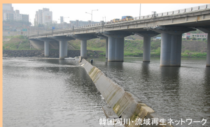
堰の撤去による生物の移動路の確保（韓国・漢灘江）
