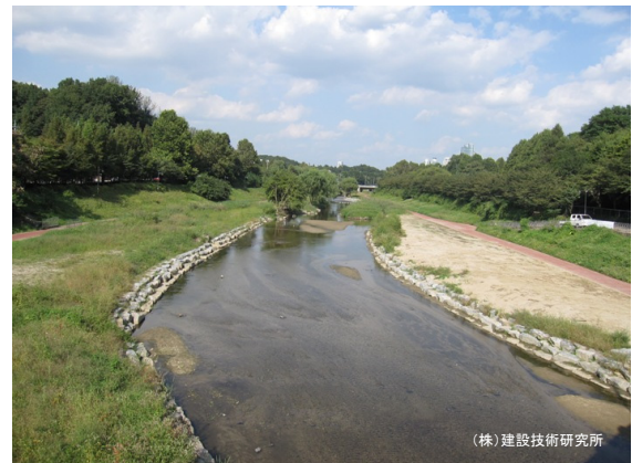
再生された区間を望む
