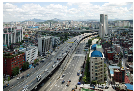
清溪川を覆う高架道路
