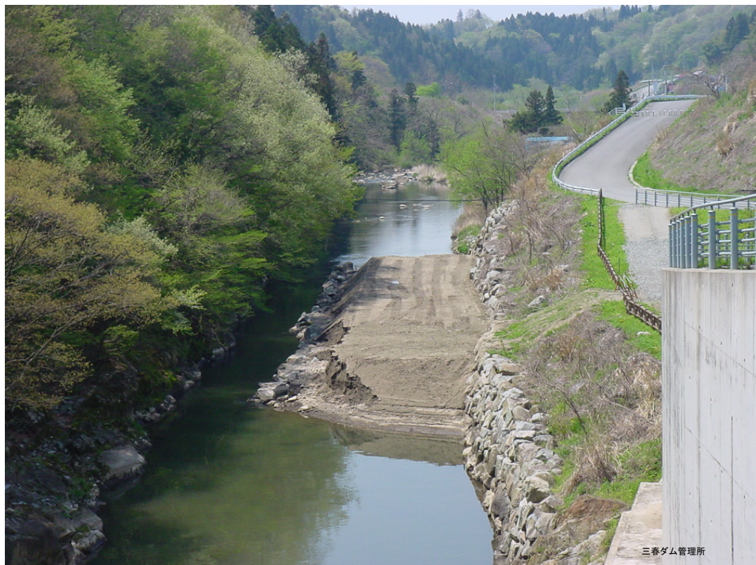
土砂供給の回復を図る試み（ダム上流に堆積した土砂を下流に置土） （日本・阿武隈川）
