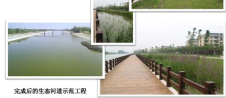
完成后的生态河道示范工程
