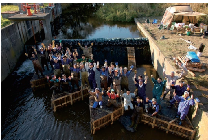
2008年10月に完成した三郎川手づくり魚道。魚類の遡上障害となっていた取水堰の下流に、木材や土のうなどで造った「三角水制」を4個並べて堰上げする構造
