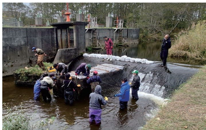
2025年10月の魚道補修作業。大雨で損壊した後の2014年に大規模補修し、右岸側の三角水制1個とコンクリートを使った「導流堤」で堰上げする構造となり、これを補修しつつ維持している
