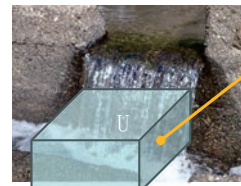
【破損や河床低下で機能していない既設魚道】 浅く、流速が大きく、壁面から剥離した流れが 発生しており、水生動物が進入・移動困難な状態
