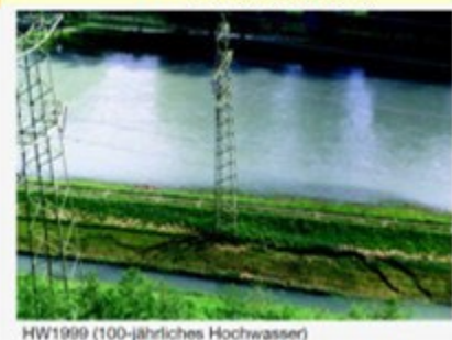
図 6 1999 年洪水(堤防亀裂)
