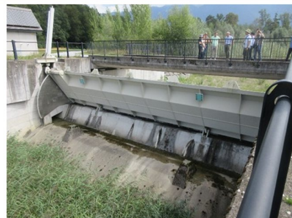
図 17 緊急放流用の堰
