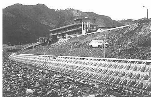
写真4 生棲号（施工中）1989年当時
