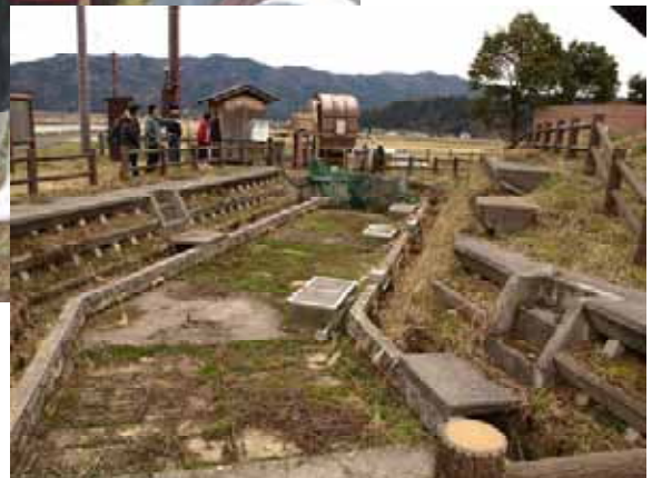
川並地区農業集落排水処理施設に付属する水質浄化施設の見学。放流された排水は、植生浄化、不織布接触酸化水路、側壁礫間酸化水路を通して余呉湖に流入しています。
