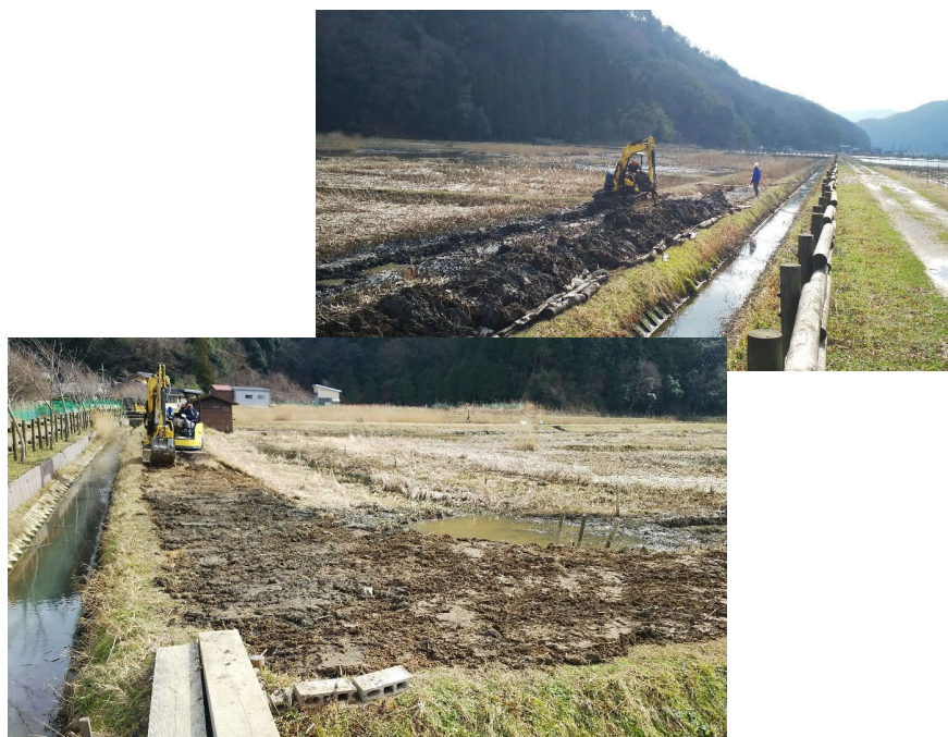
戸島湿地では、湿地管理作業の効率化の観点から、管理用の道路を延長しました。
