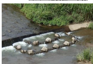
魚道整備(八代水門)
