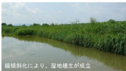
緩傾斜化により、湿地植生が成立
