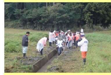
導水路を掃除して頂きました
