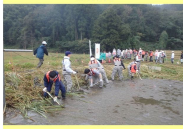
湿地内の堆積土砂を撤去して頂きました
