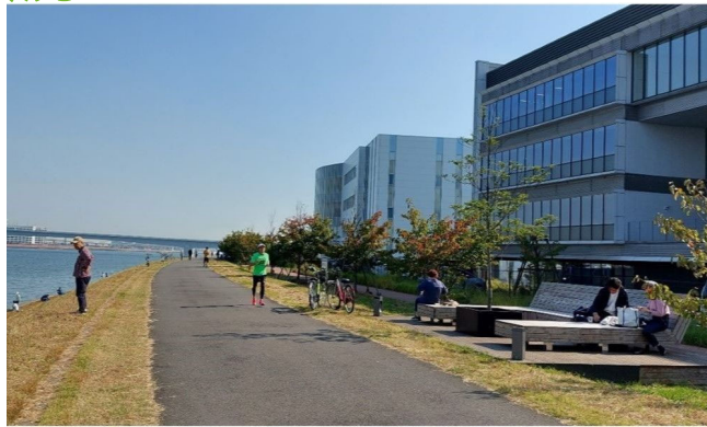
多摩川殿町第一地区高規格堤防
