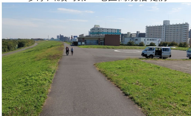
荒川北赤羽地区高規格堤防
