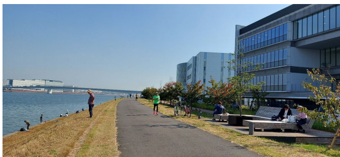
殿町第一地区高規格堤防（多摩川）
