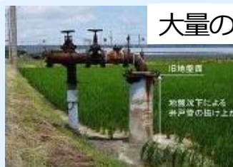
地盤沈下による井戸の抜け上がり (濃尾平野)
