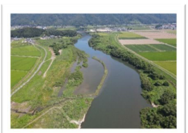
掘削による湿地創出(河川) (白野川片粕地区、福井県)
