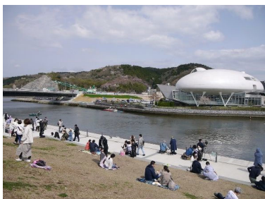
堤防の利用の様子
