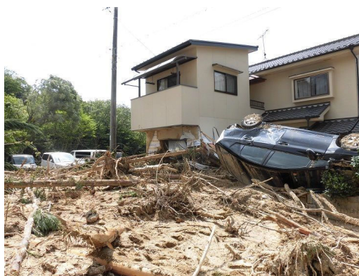
広島県熊野町 被害状況
