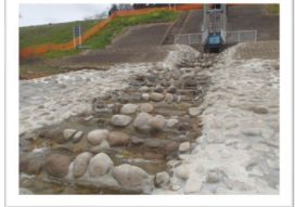
樋門などの改修(落差を解消) (利根運河 境田樋管、千葉県)
