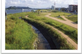
魚道の設置 (遠賀川多自然型魚道、福岡県)
