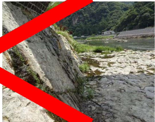
他工区の岩盤掘削形状
