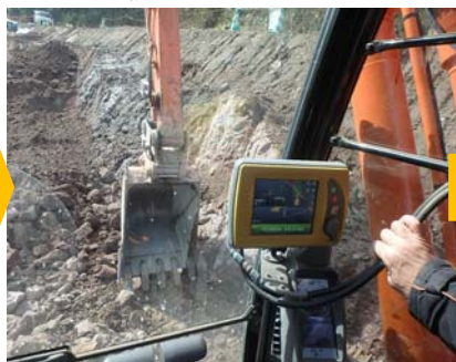
ICT建設機械による施工
