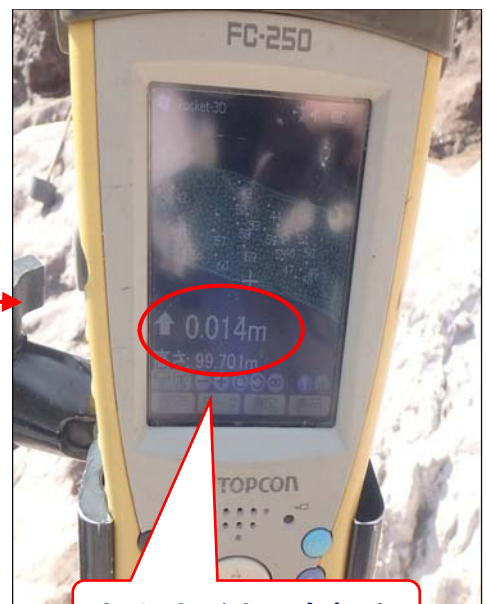
掘削高が表示される
