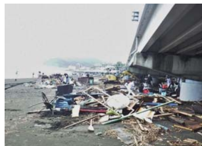
台風12号（H30.7.28-29）による 湯河原海岸海の家被害事例（神奈川県） 出典：国土交通省
