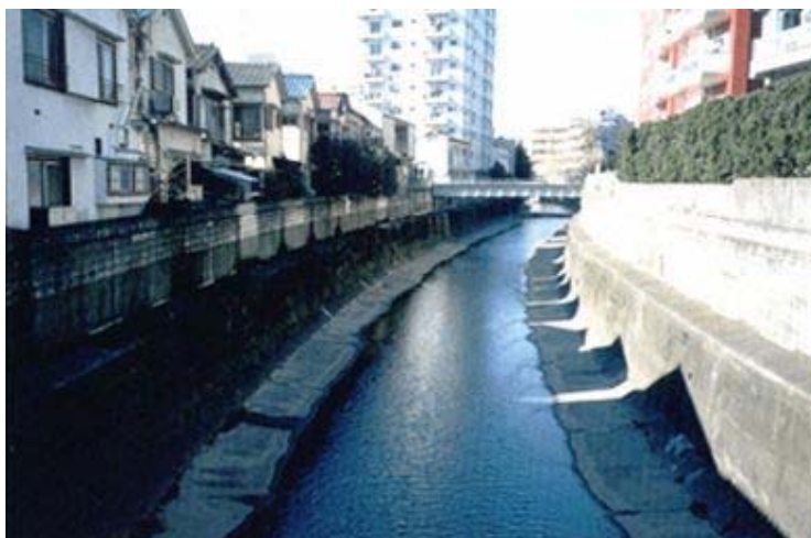
三面張り水路となった神田川
