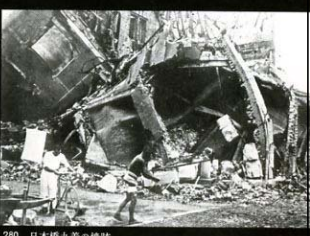
280 日本橋丸善の焼跡
