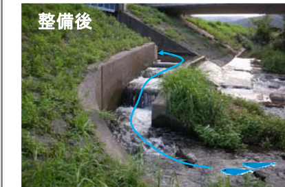
樋門出口と河川の水面落差解消
