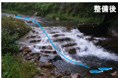
横断構造物の落差解消
