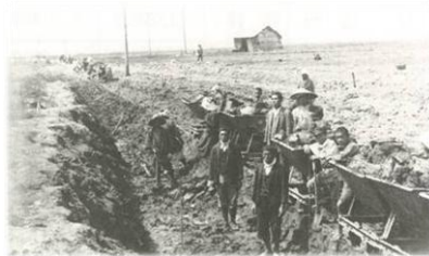
第一期改修工事の状況
