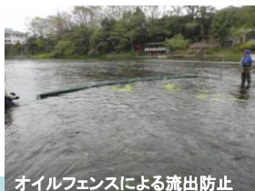
オイルフェンスによる流出防止
