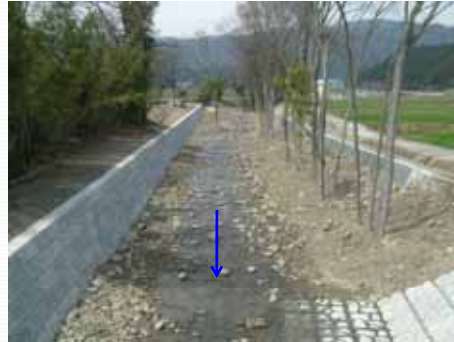
工事完了直後
