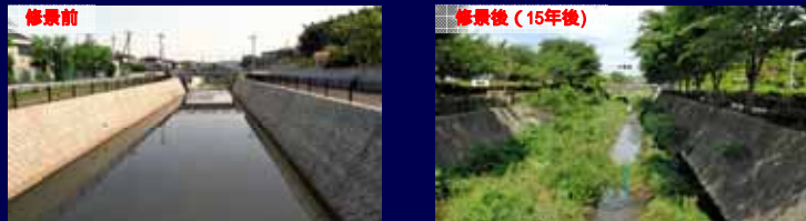
護岸天端部に植樹した事例(いたち川:横浜市)
