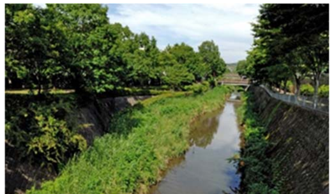
図-16 改修後のいたち川(天神橋～日東橋区間) 11)
