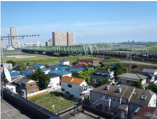
写真－1 北小岩地区（高規格堤防整備着手前）
