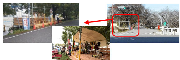
図 - 2 堤防(乙川右岸殿橋付近)裏法の活用事例
