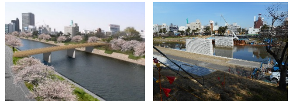
写真 - 1 人道橋の建設状況
