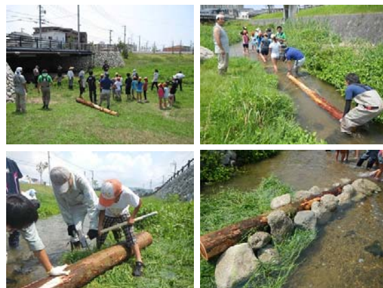
写真-1 上西郷川現地研修会 (水制の施工体験)
