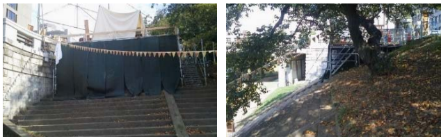
写真-3 殿橋下流側取付部（堤外）に設置したテラス
