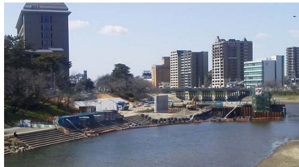
写真-4 人道橋の建設状況（平成29年度3月時点）
