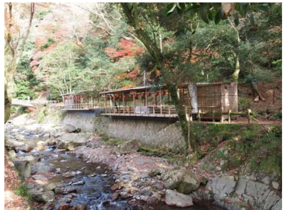
写真－3 箕面川床の現地写真（営業期間外）
