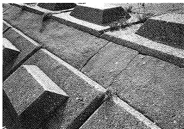
写真－1 城南海岸の堤防劣化状況
