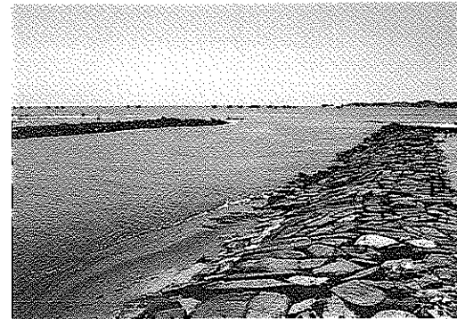
●野蒜港築港の跡・外港周辺
