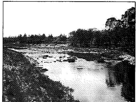
既存の樹木を残しながら、現地発生材料を有効的に利用し、もとの地形を尊重して整備した例。
