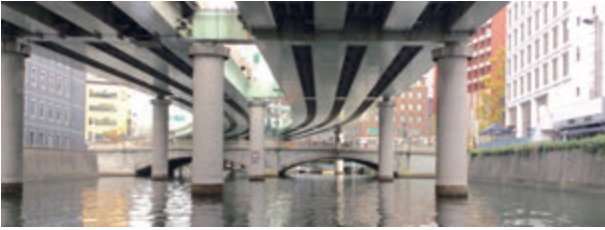
高速道路に覆われる日本橋付近の日本橋川
