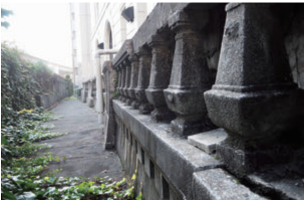
堤防(左側)との間に見た構築物は堤防工事をした際に見えていた部分の下半分を埋め立てた。撮影 阿部彰
