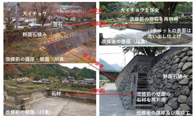
図-10 改修前後の築堤護岸整備状況
