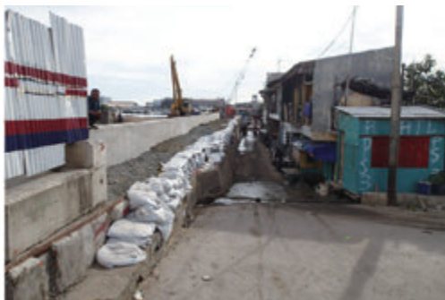
[越流対策のため積まれた土嚢]
