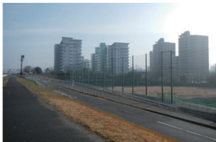
完成後の淀川大東地区
