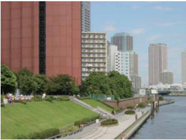
写真-8 高規格な堤防は緩傾斜護岸を実現し、川の開放感をもたらす
