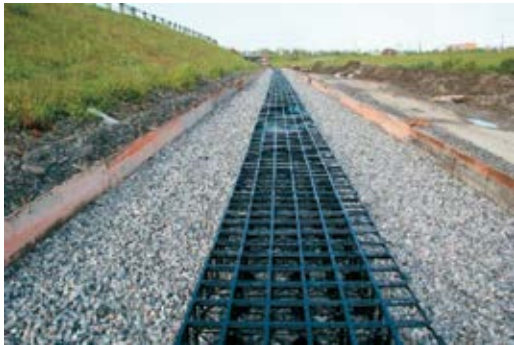
図9 砂利層とパイプ構造
