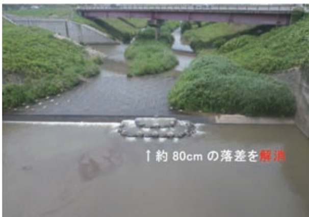
写真-5 八代水門の落差改善状況
