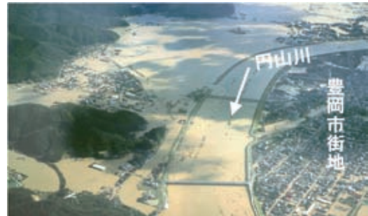
写真-1 平成16年台風23号による被害
