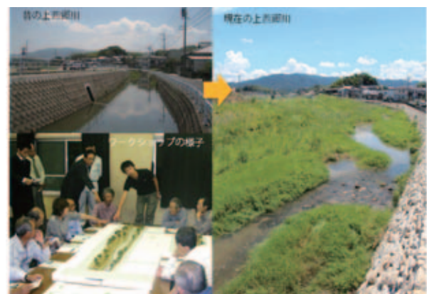
図2 上西郷川での多自然川づくりの取り組み
