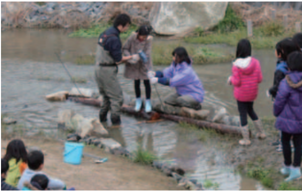
図7 間伐材水制施工時の様子
