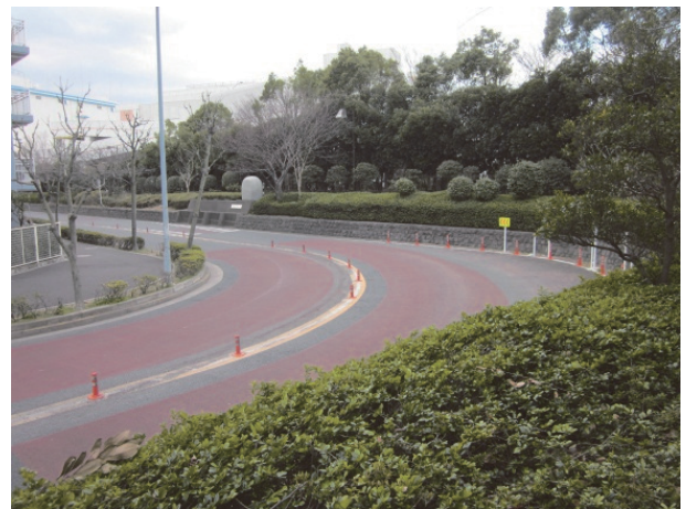
図17 旧葛西海岸堤防の活用例
