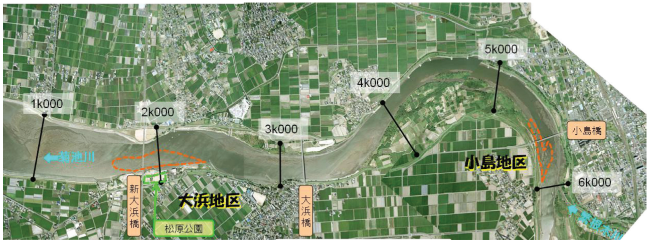
図-9 自然再生実施箇所
