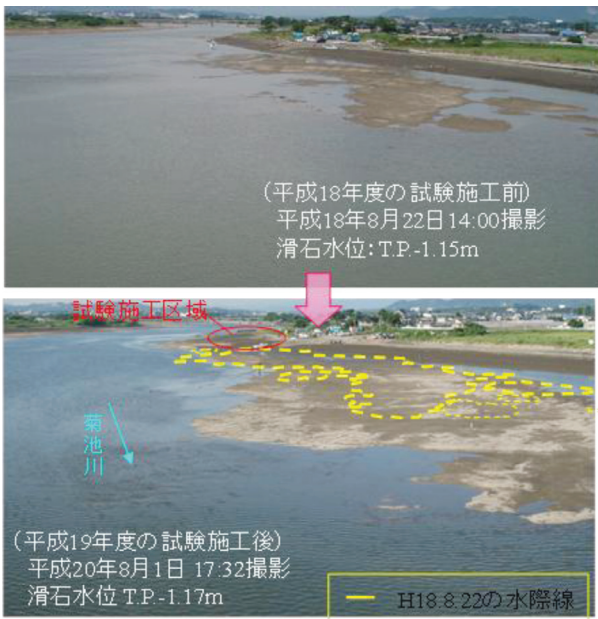
図-13 試験施工後の砂州変化
