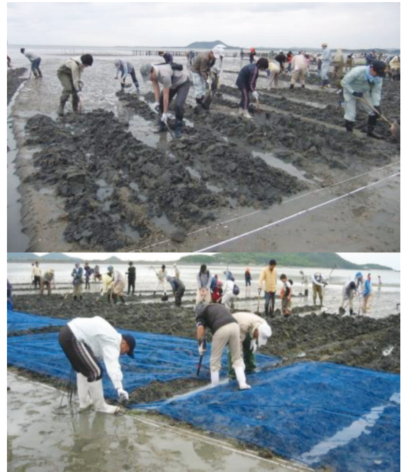
図-8 干潟耕転(上)及び被覆網設置(下)の様子
