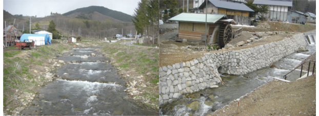
写真-10 完成後の写真 (控え護岸区間)
