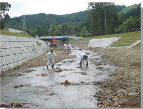
写真-14 職員と業者による河床材の敷設
