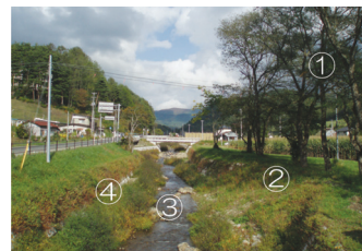
写真-7 施工における工夫
