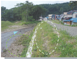
写真-13 天端への覆土、水際の河床材
