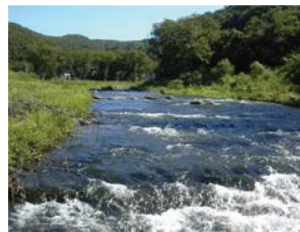
写真-2 全断面緩傾斜落差工
