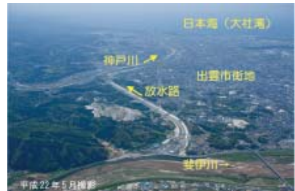
工事の進む斐伊川放水路
