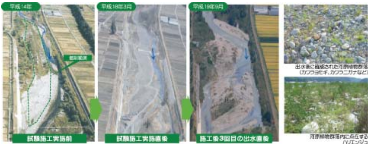
図2. 試験施工地における出水後の河道変化状況(三峰川青島地区)
