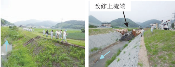
写真-2 現地踏査の状況 (小野田川)
