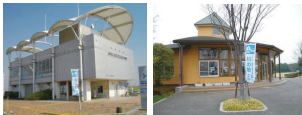
写真-1 平成20年度 社会実験施設
